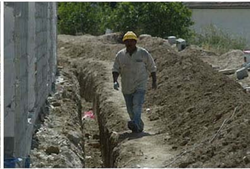
obra viznar (37).jpg
