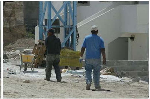
obra viznar (20).jpg
