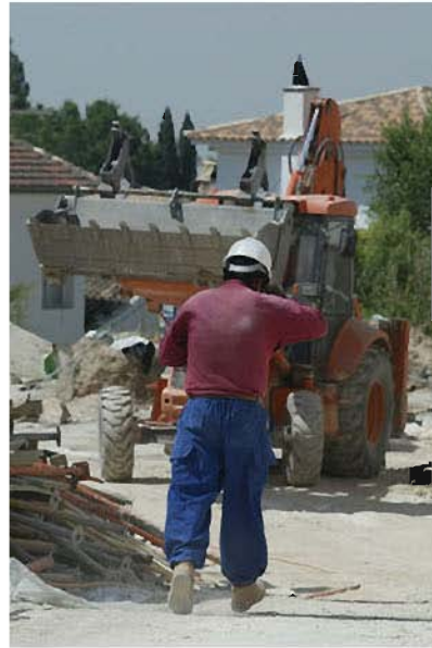
obra viznar (28).jpg
