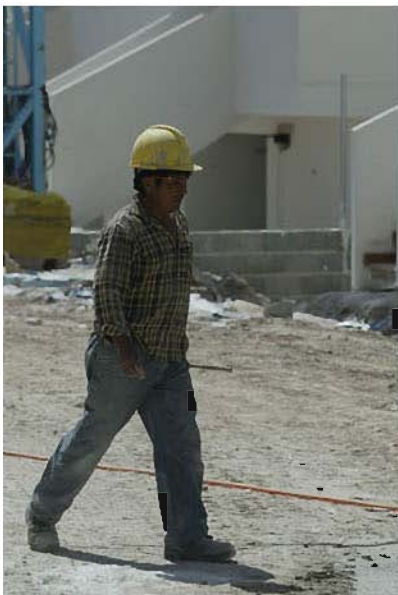
obra viznar (24).jpg
