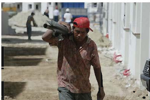
obra viznar (60).jpg
