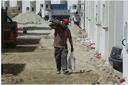
obra viznar (54).jpg
