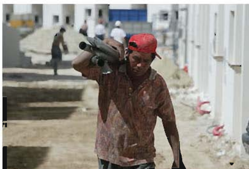
obra viznar (61).jpg
