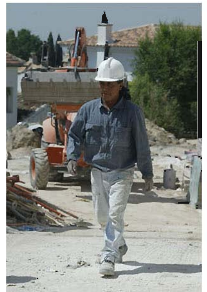
obra viznar (26).jpg
