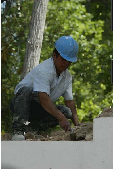
obra viznar (09).jpg
