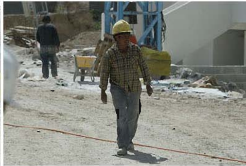
obra viznar (22).jpg
