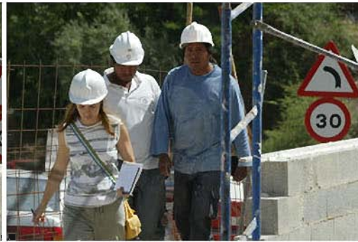
obra viznar (46).jpg
