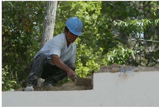
obra viznar (12).jpg
