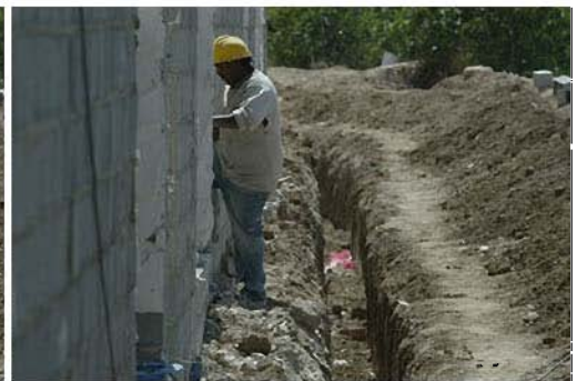
obra viznar (44).jpg
