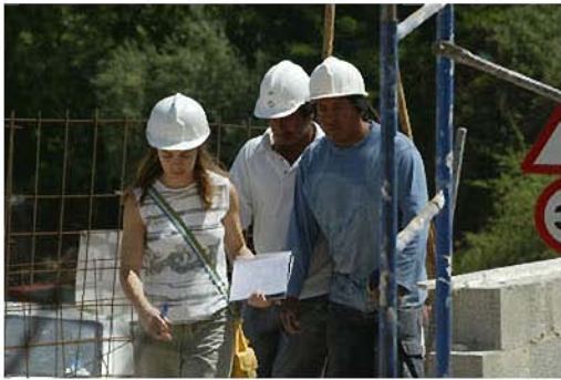
obra viznar (45).jpg
