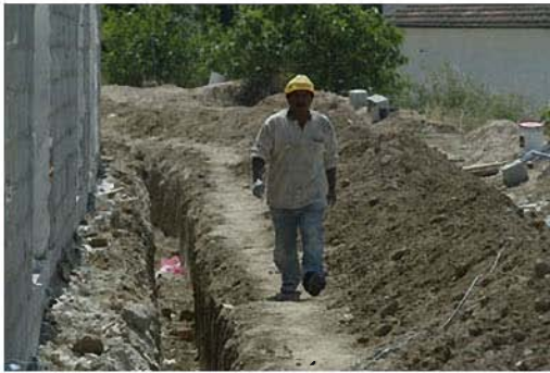
obra viznar (36).jpg
