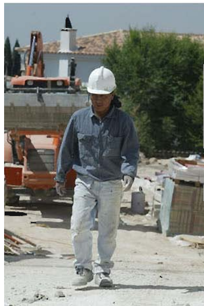
obra viznar (25).jpg
