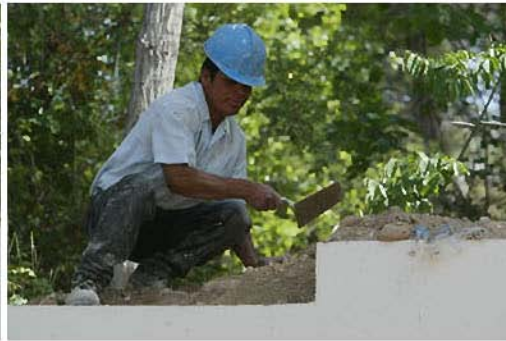
obra viznar (13).jpg
