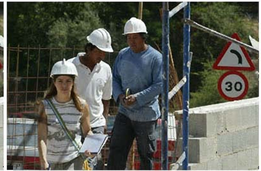
obra viznar (47).jpg
