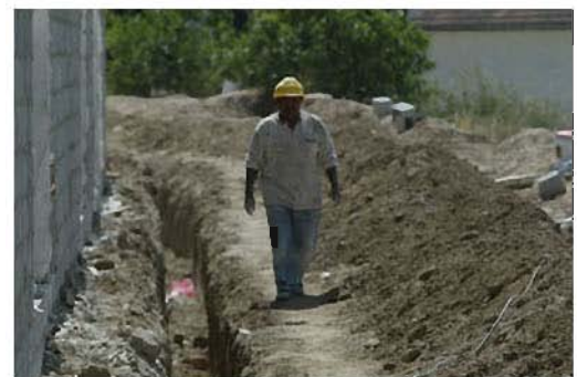
obra viznar (35).jpg
