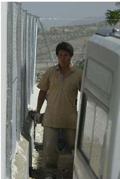
obra viznar (15).jpg
