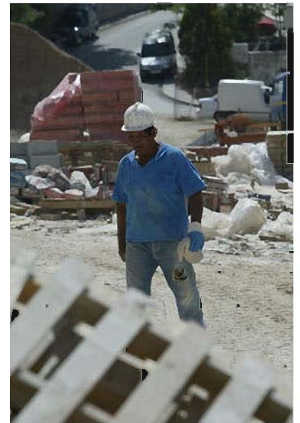
obra viznar (32).jpg
