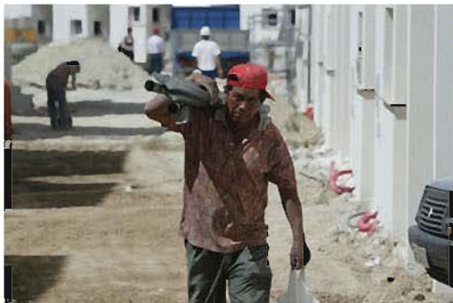
obra viznar (57).jpg
