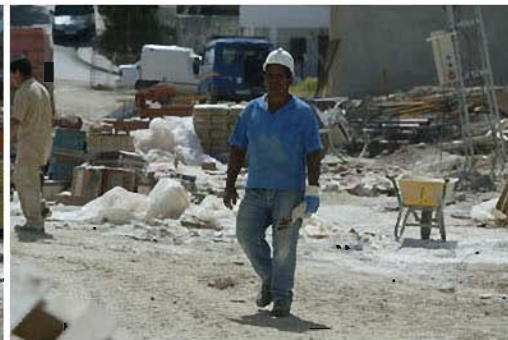
obra viznar (31).jpg
