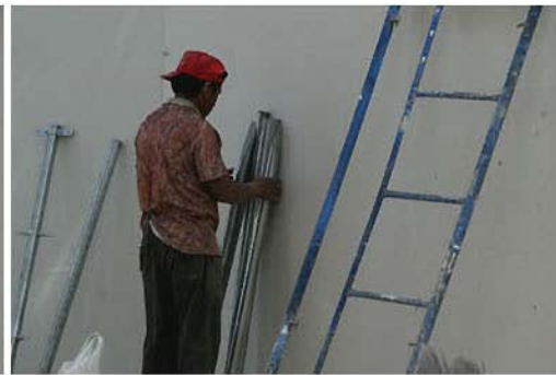
obra viznar (04).jpg
