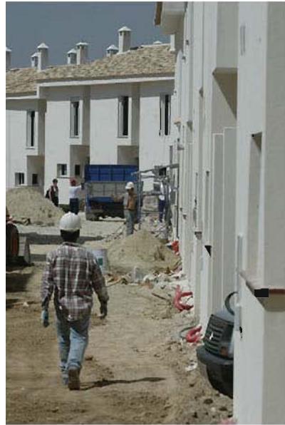
obra viznar (01).jpg
