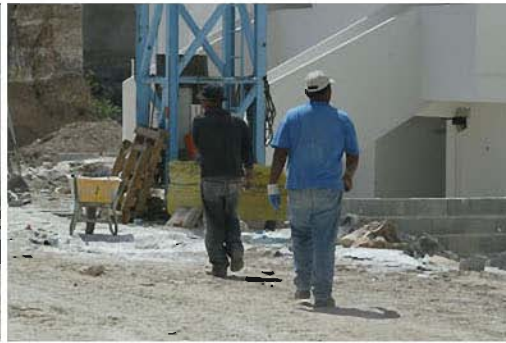
obra viznar (19).jpg
