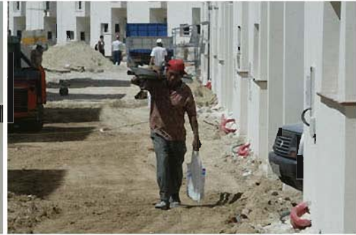
obra viznar (56).jpg
