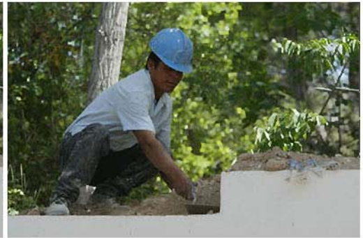
obra viznar (14).jpg
