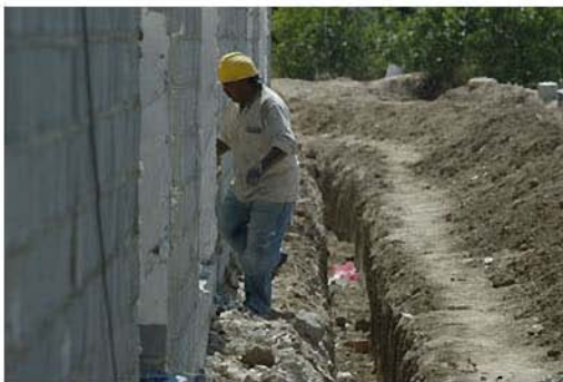
obra viznar (42).jpg
