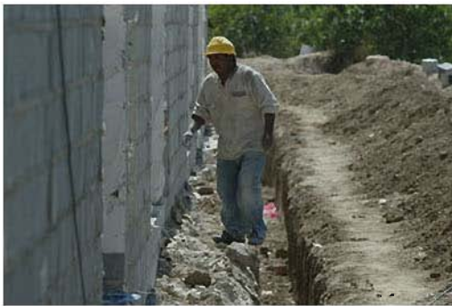
obra viznar (39).jpg
