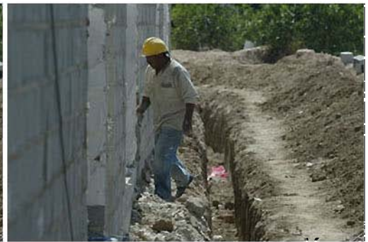
obra viznar (41).jpg
