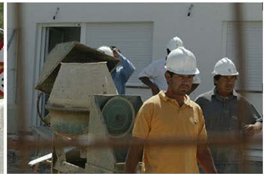
obra viznar (50).jpg
