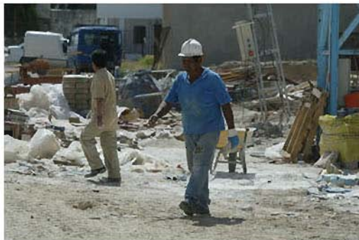
obra viznar (30).jpg
