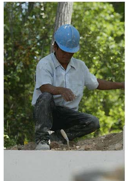
obra viznar (08).jpg
