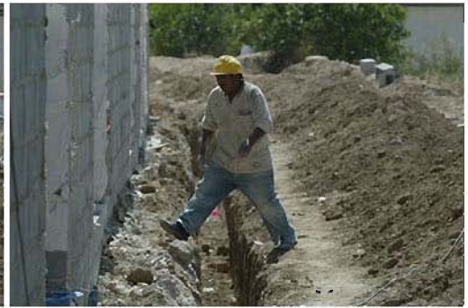
obra viznar (38).jpg
