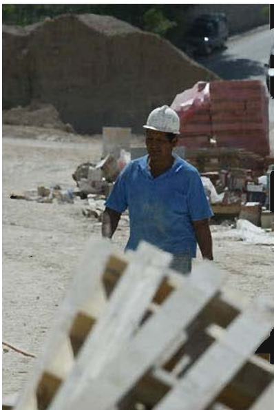
obra viznar (33).jpg
