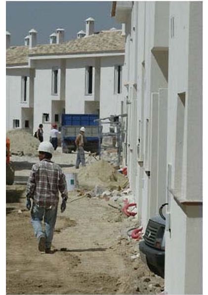
obra viznar (02).jpg
