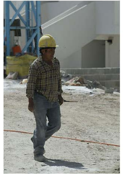
obra viznar (23).jpg
