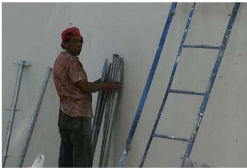
obra viznar (03).jpg
