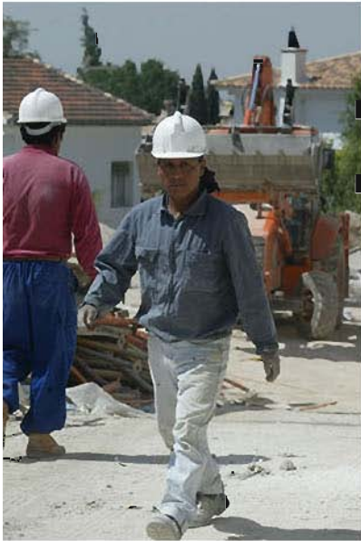
obra viznar (27).jpg
