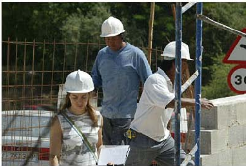
obra viznar (48).jpg
