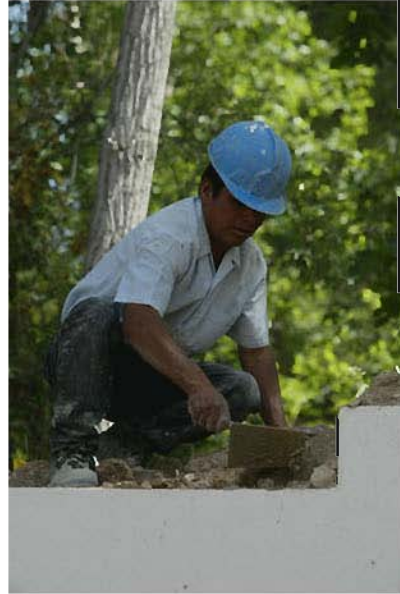
obra viznar (10).jpg
