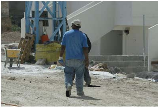
obra viznar (18).jpg
