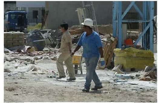
obra viznar (29).jpg
