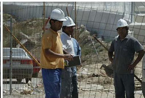
obra viznar (52).jpg
