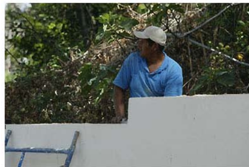
obra viznar (07).jpg
