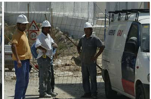
obra viznar (53).jpg
