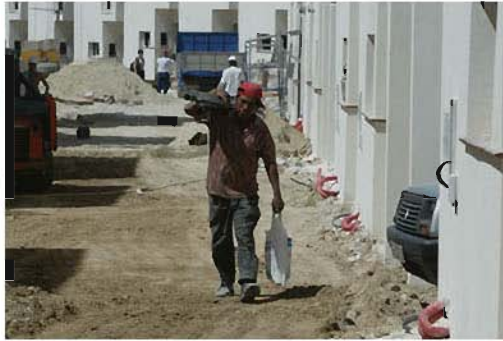
obra viznar (55).jpg
