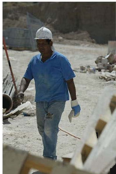
obra viznar (34).jpg
