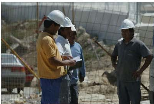
obra viznar (51).jpg
