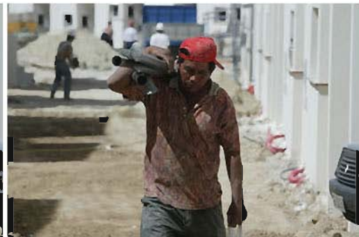
obra viznar (59).jpg
