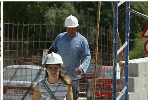
obra viznar (49).jpg
