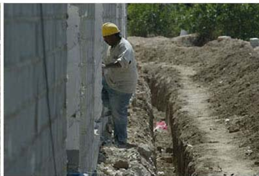
obra viznar (43).jpg
