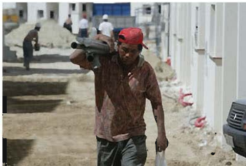
obra viznar (58).jpg
