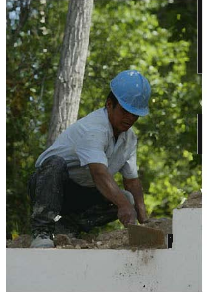
obra viznar (11).jpg
