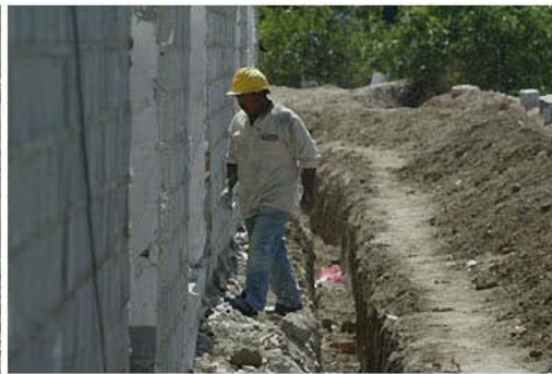
obra viznar (40).jpg
