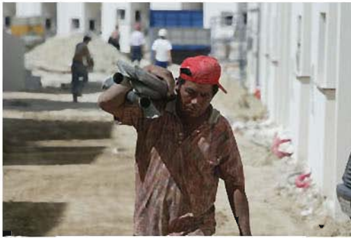
obra viznar (0).jpg
