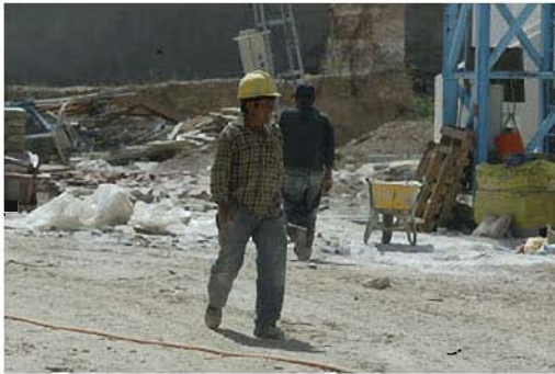
obra viznar (21).jpg
