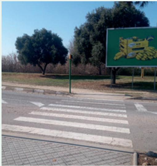
Pas de vianants al carrer K d'accés al pont de Mercabarna sense semàfor per a vianants
