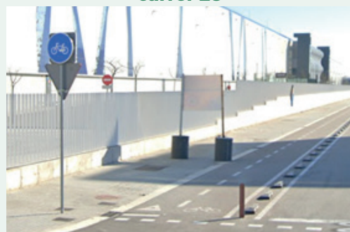
Finalització del carril bici del carrer 28
